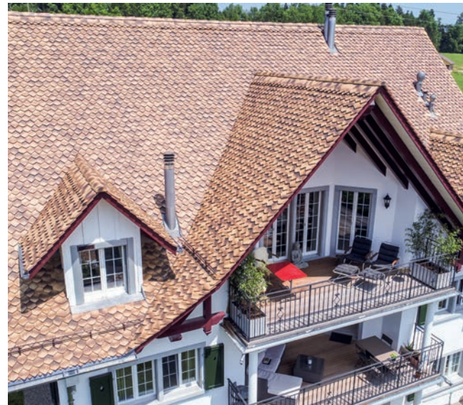
Kontrolle eines neuen Daches.
