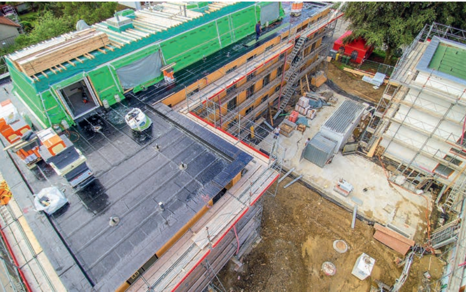
Erstellen einer Baudokumentation mit allen entsprechenden Vermessungen.
